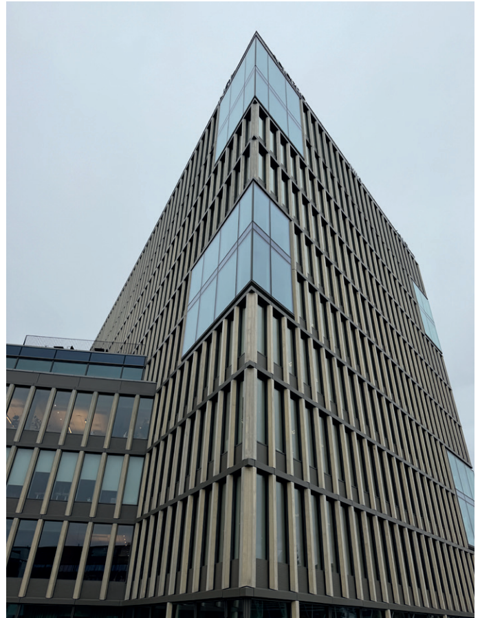
Det er store vinduspartier oppover etasjene.
