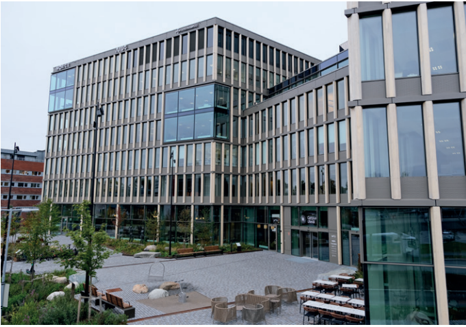
Fasaden er blant annet kledd med prefabriserte elementer, levert ferdig med glass, aluminium, isolasjon og solskjerming.
